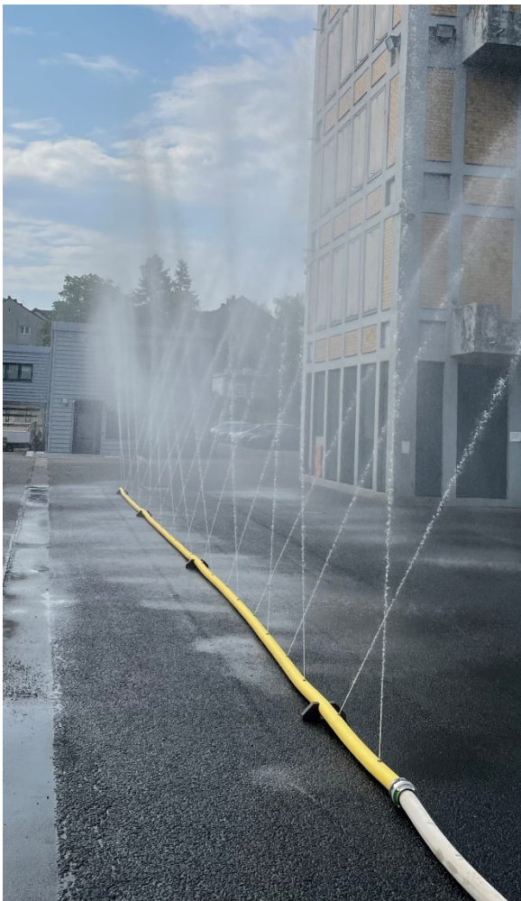
Abb. 7.10: Düsenschlauch im Einsatz [A.Seiffen, BF Offenbach]
